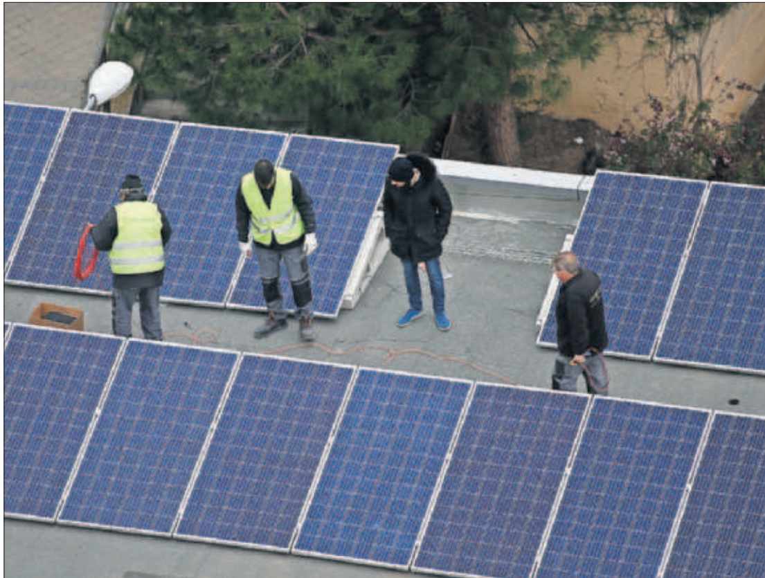
Instalación de placas solares en una oficina de Correos en Madrid, el 3 de marzo. / LUIS SEVILLANO
